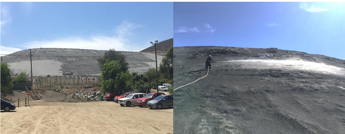
Ilustración 5: Tranque III, aplicación de aditivo
