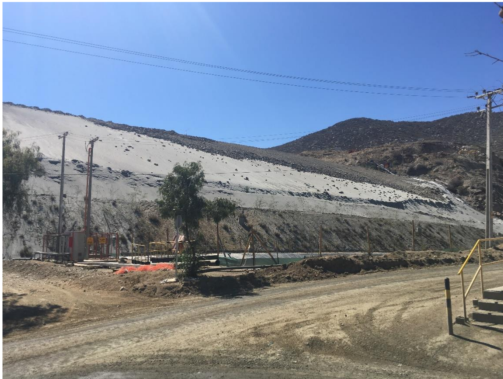
Ilustración 11: Tranque III, sector no aplicado por obras de cierre
