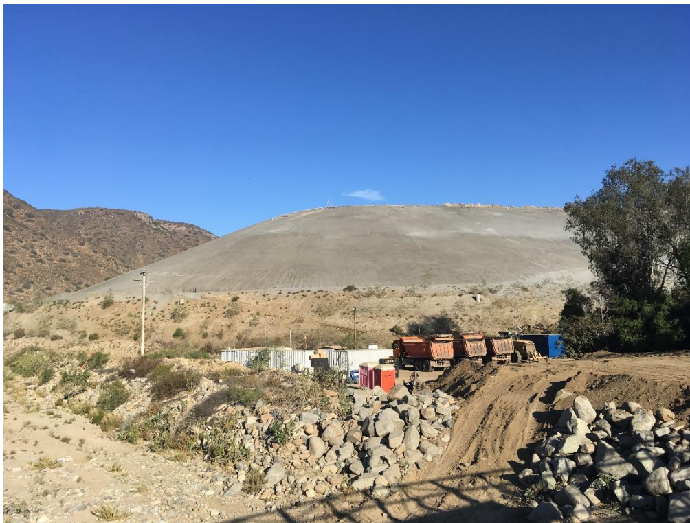
Ilustración 9: Tranque III, vista general luego de aplicado
